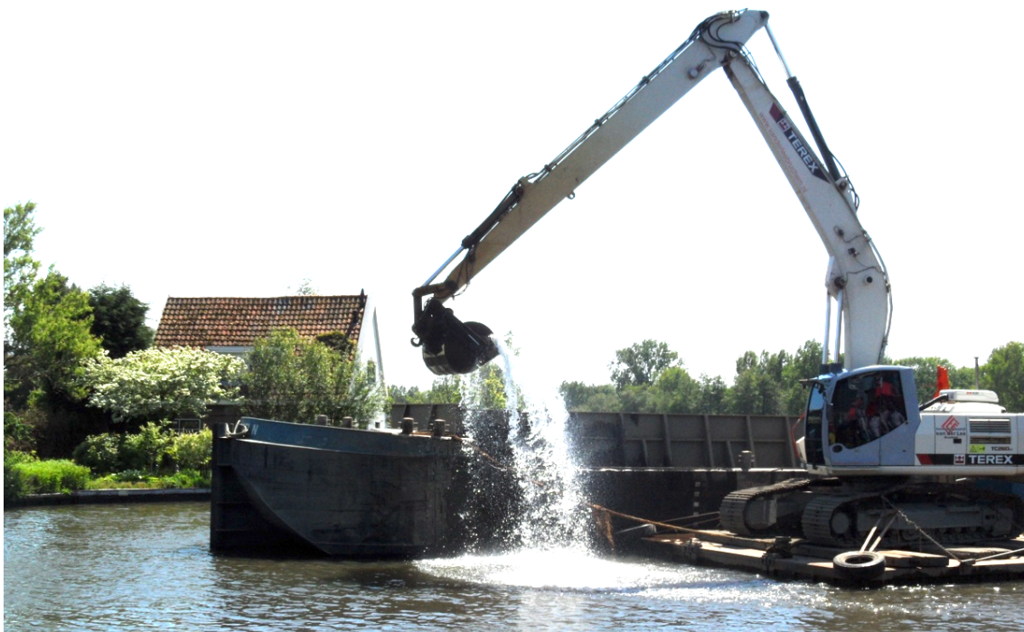
Afbeelding 1. Baggeren op rivier De Vecht
