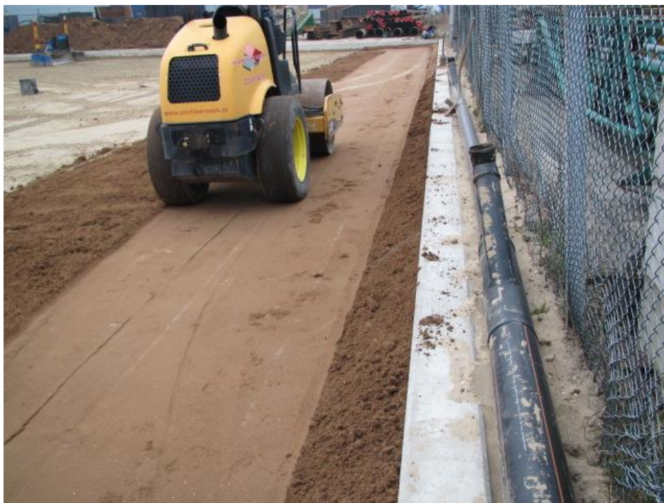
Foto: aanbrengen van zand-bentoniëtpolymeergelmengsel.
