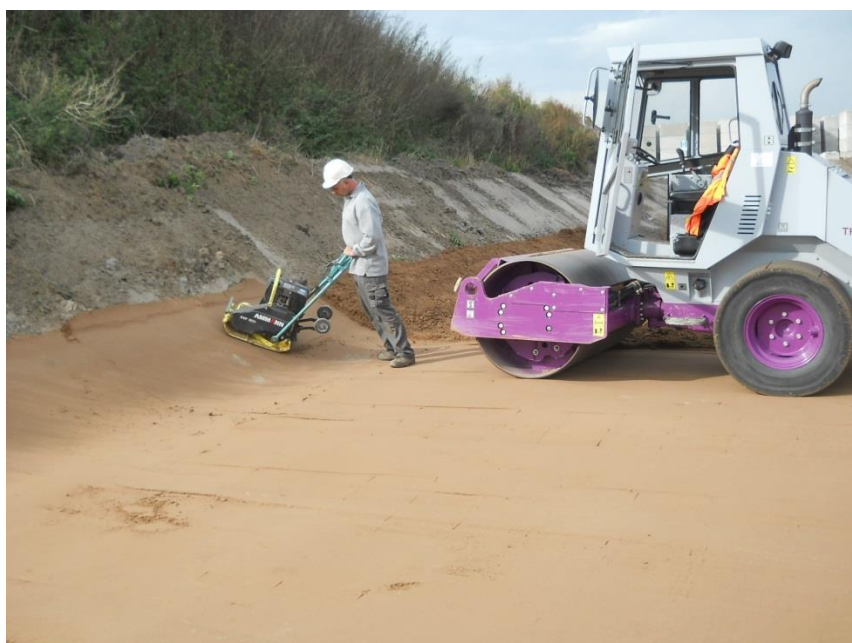
Foto: voorbeeld van aanbrengen van voldoende afschot.
