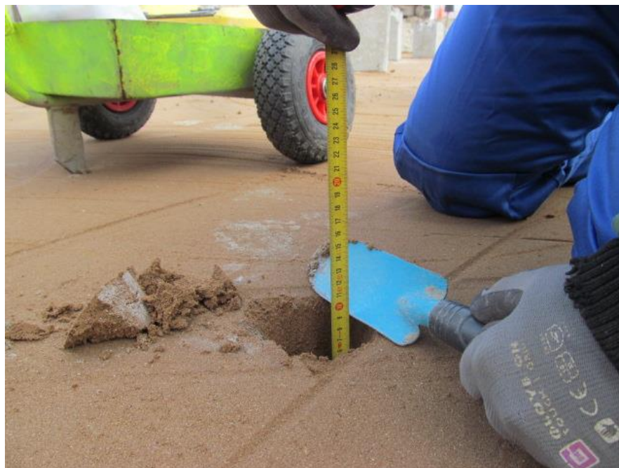
Foto: controle van dikte van minerale laag.
