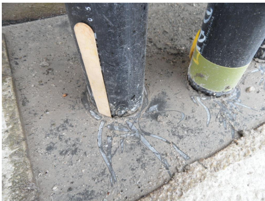
Foto: voorbeeld niet afgedichte doorvoer.
