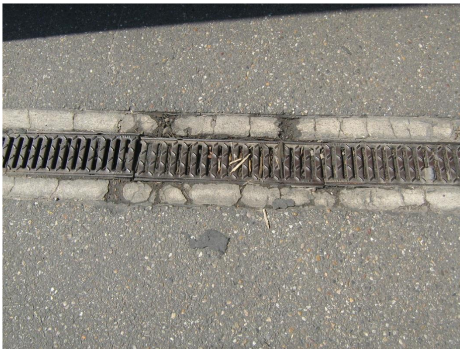
Foto: aansluiting met lijngoot niet vloeistofdicht afgewerkt.
