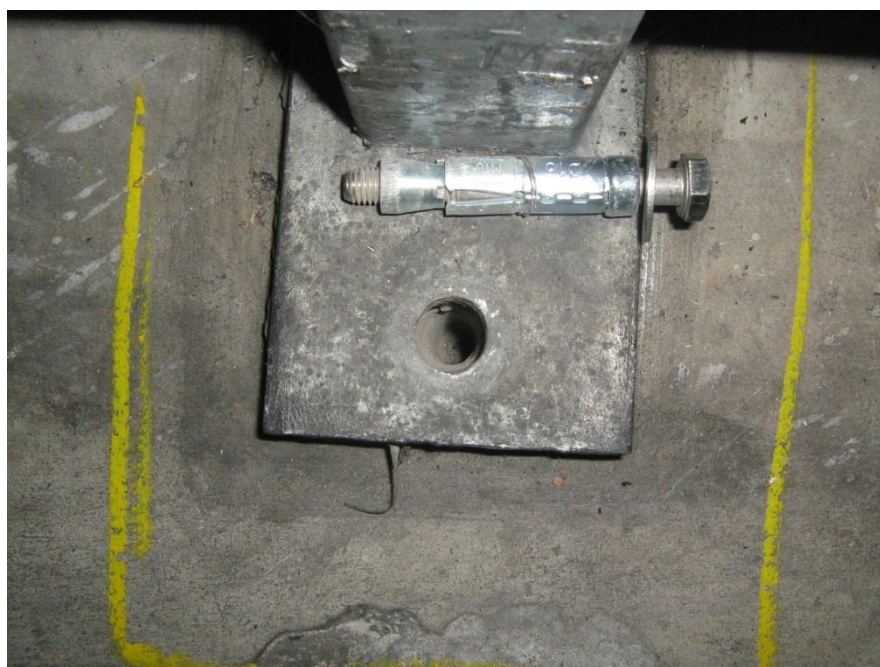
Foto: voorbeeld niet juist afgedicht boorgat.
