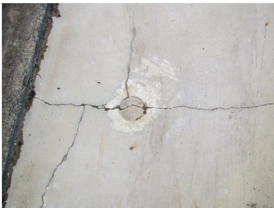
Foto: voorbeeld scheurvorming.
