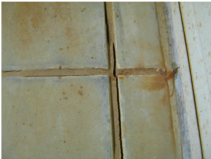
Foto: beschadigde kitvoeg.
