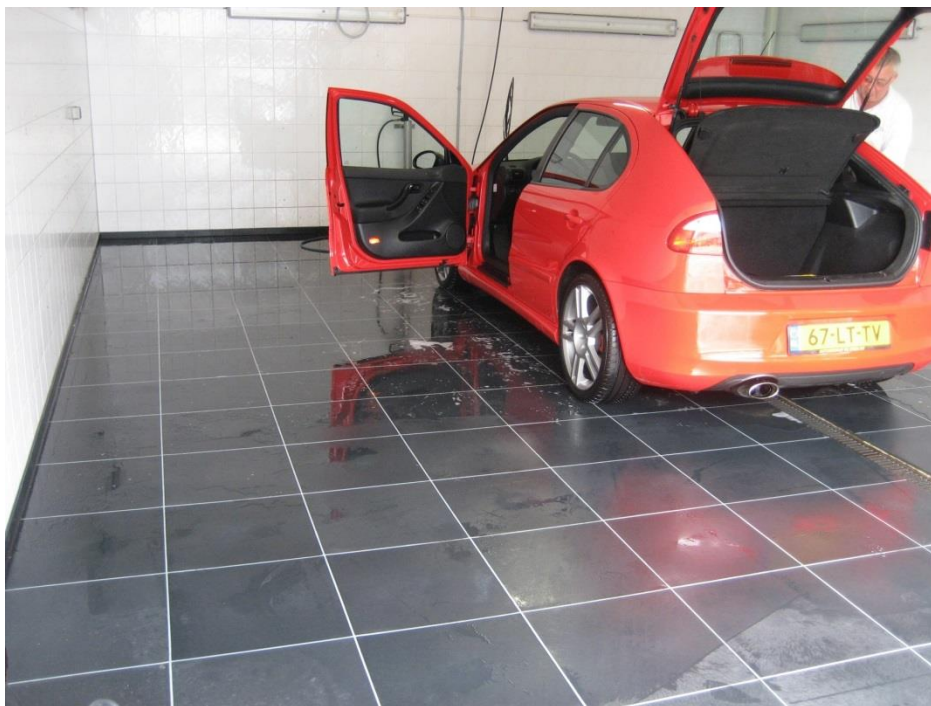
Foto: vloer uitgevoerd met kunststof elementen.
