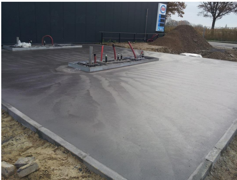
Foto: aanleg van vloeistofdichte betonvloer.
