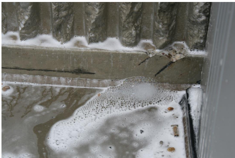
Foto: luchtlekkage bij aansluiting.
