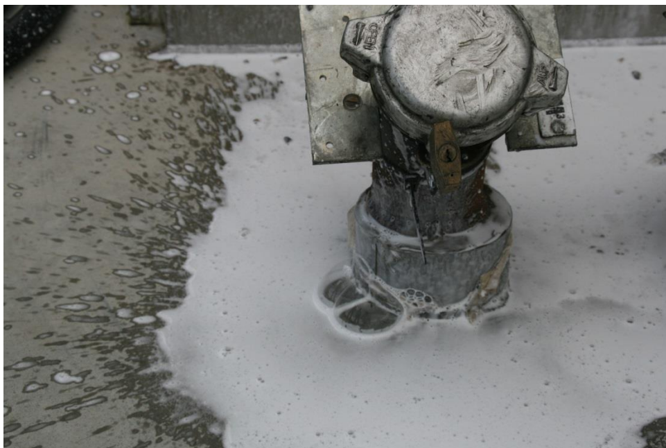
Foto: luchtlekkage bij doorvoer.
