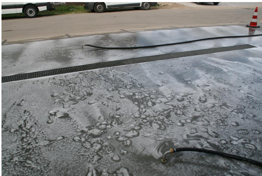
Foto: voorbeeld aanbrengen van luchtinbrengpunten.
