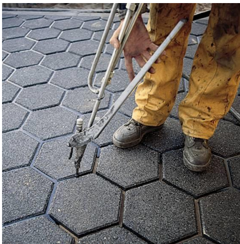
Foto: voorbeeld van het aanbrengen van voegvulmassa
