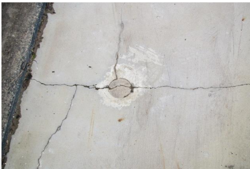
Foto: Voorbeeld van scheur.
