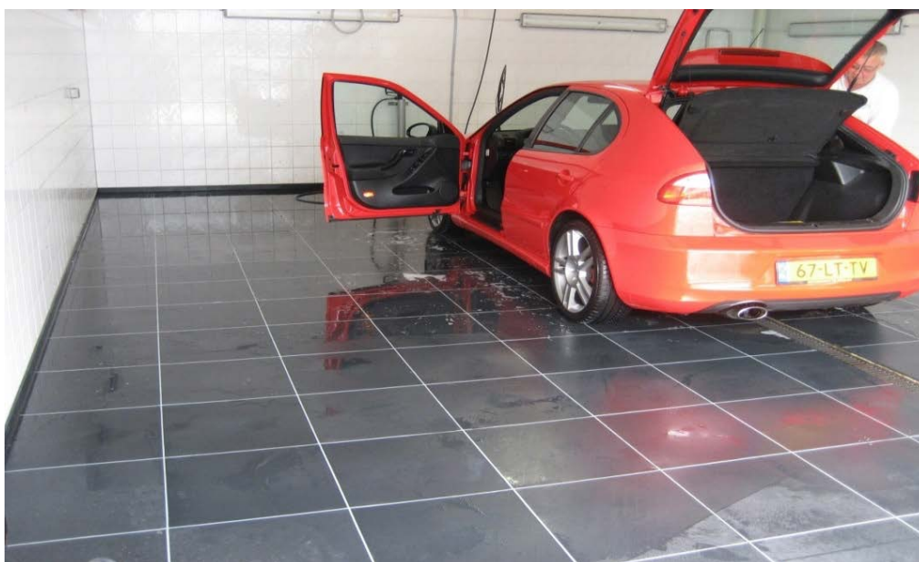
Foto: Vloer uitgevoerd met kunststof elementen.
