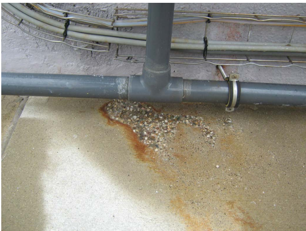
Foto: Voorbeeld van chemische aantasting.
