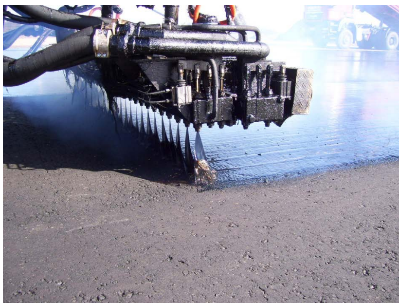
Foto: Aanleg vloeistofdichte asfaltconstructie.
