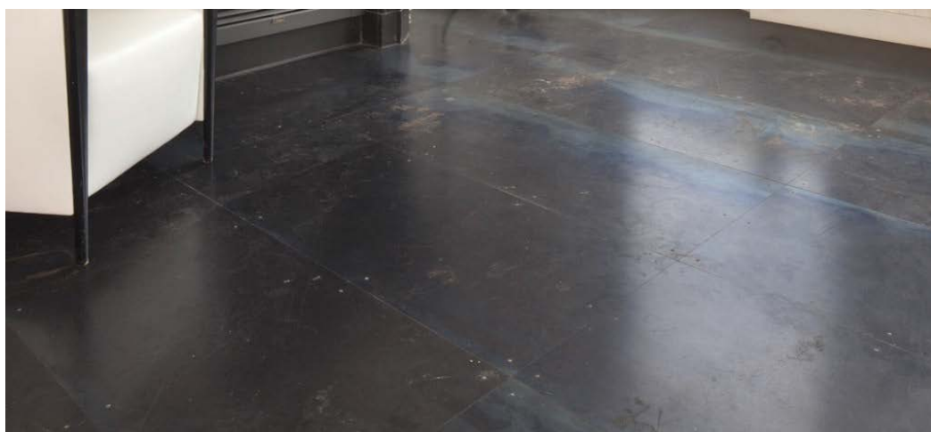
Foto: Voorziening van aan elkaar gelaste metaalplaten.
