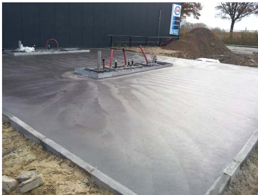
Foto: Aanleg van vloeistofdichte betonvloer.
