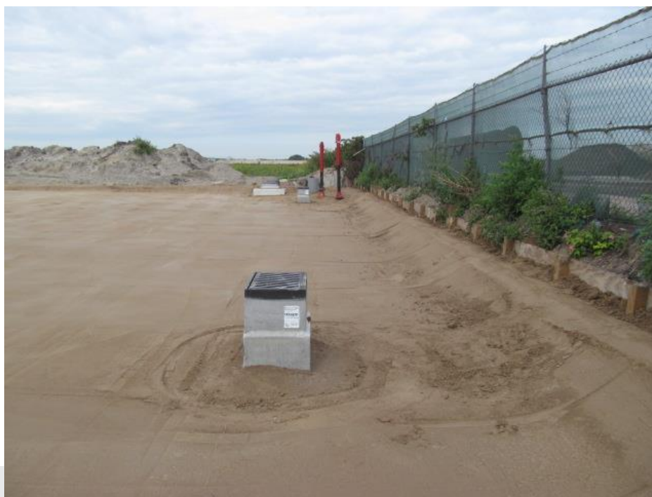
Foto: Doorvoer in voorziening.
