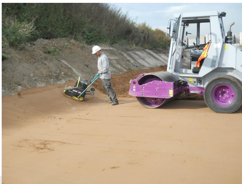
Foto: Voorbeeld van aanbrengen van voldoende afschot.
