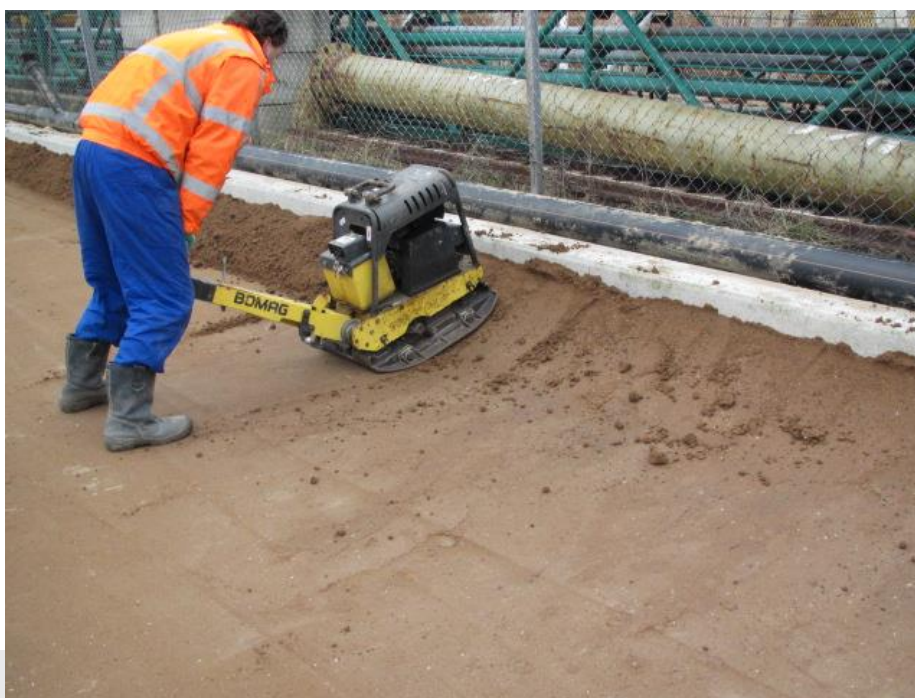
Foto: Aanbrengen minerale laag ter plaatse van slecht te verdichten locatie.
