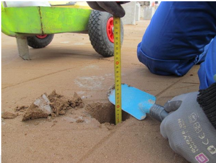
Foto: Controle van dikte van minerale laag.
