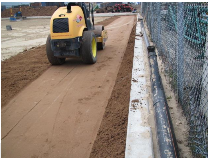
Foto: Aanbrengen van zand-bentonietpolymeergelmengsel.
