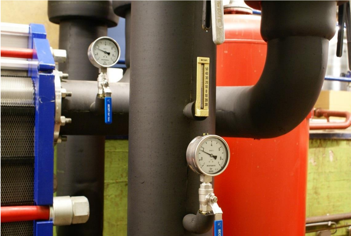
Meetinstrumenten: indicatoren voor druk en temperatuur.
