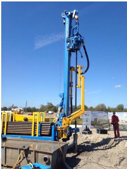
Boring in uitvoering.
