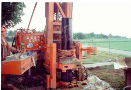
Pulsboring in uitvoering.
