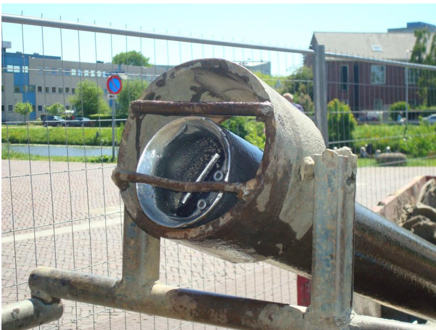
Onderzijde van een puls, met pulsklep
