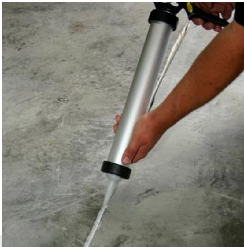
Foto: Aanbrengen voegmassa.
