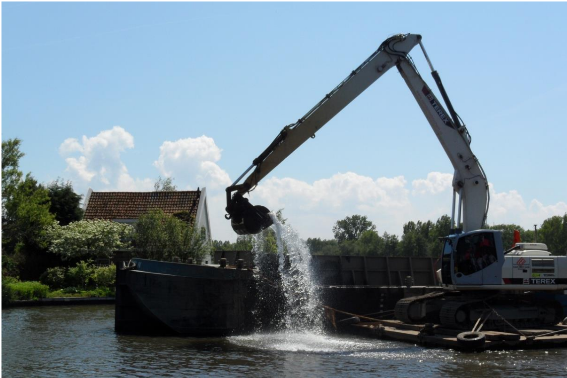
Afbeelding 1. Baggeren op rivier De Vecht
