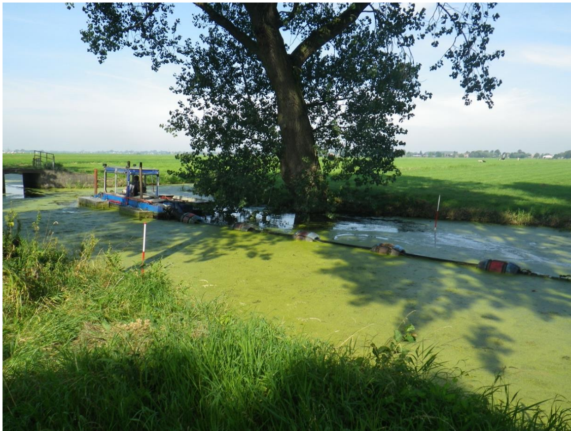
Afbeelding 2. Baggeren met cutterzuiger in veenweidegebied
