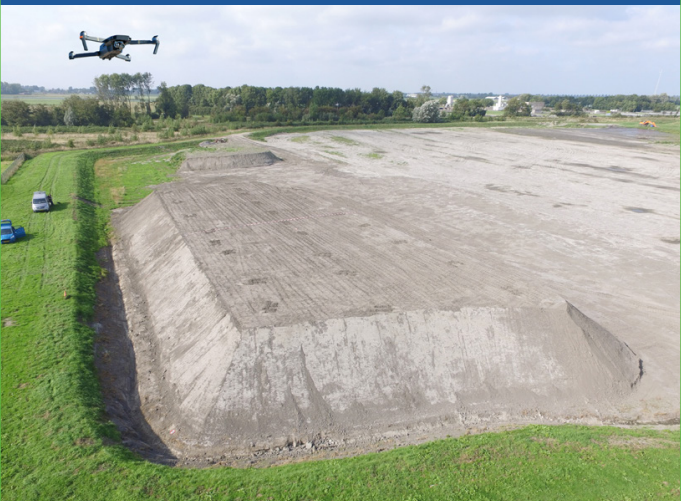
Voorbeeld resultaat fotogrammetrie: 3D model gronddepot (Foto: Grondslag)
