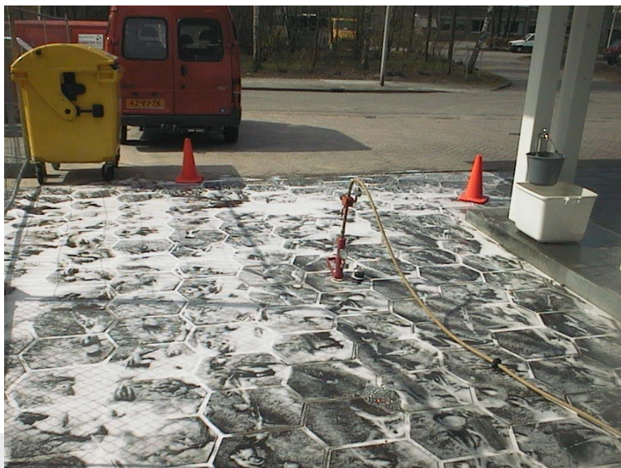
Foto: Inspectie uitgevoerd overeenkomstig protocol 6704.
