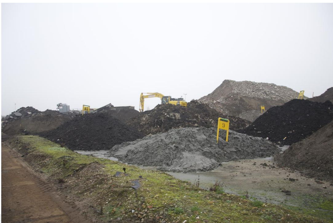
Foto: Mogelijke inspectielocatie voor geo-elektrische meting.
