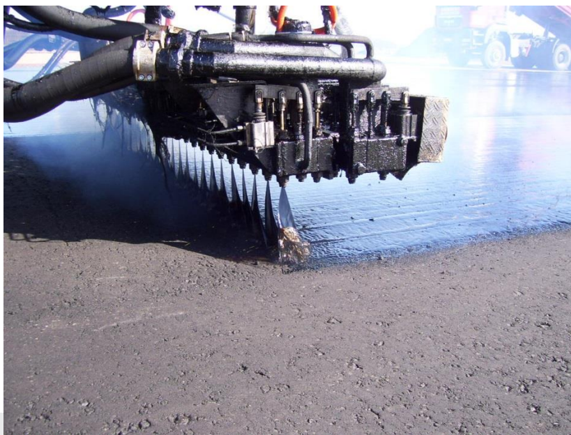
Foto: Aanleg vloeistofdichte asfaltconstructie.
