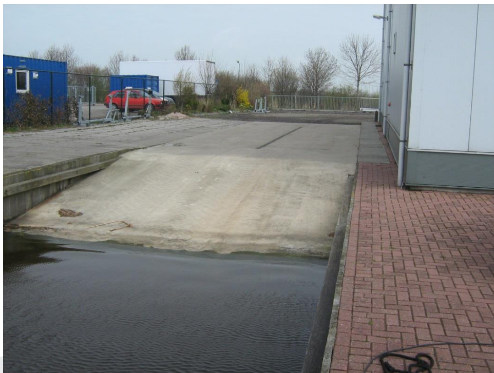
Foto: Voorbeeld van een aandachtspunt bij afschot richting oppervlaktewater.
